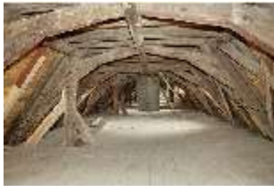
BaRes.II, Gebsattelbau, Dachstuhl, DI017653, BSV
