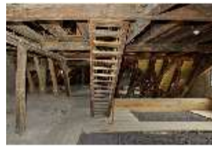
BaRes.II, Gebsattelbau, Dachstuhl, DI017651, BSV
