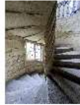
BaRes.II, Wendeltreppe, DI020690, BSV-
