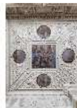
BaRes.II, Decke, Inneres Vorzimmer der Kurfürstenzimmer, DI015666, BSV
