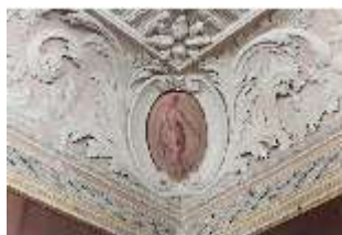
BaRes.II, Stuckdecke (Detail), Schlafzimmer der Kurfürstenzimmer, DI015622, RSV
