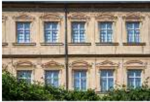
BaRes.I, Fassade des Gebattelbaus, DI020397, BSV
