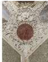
BaRes.II, Rondo an der Decke, Vorzimmer R. 20, DI015614, BSV
