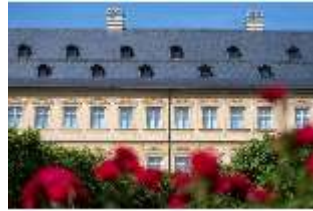
BaRes.I, Fassade des Gebattelbaus, DI020398, BSV
