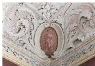
BaRes.II, Stuckdecke (Detail), Schlafzimmer der Kurfürstenzimmer, DI015623, RSV
