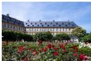
BaRes.V, Rosengarten, Hadergassenflügel (Gebtsattelbau), DI020418, BSV
