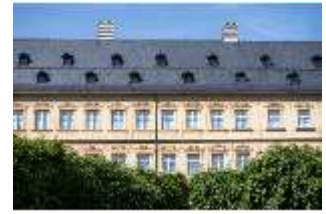
BaRes.I, Fassade des Gebattelbaus, DI020396, BSV
