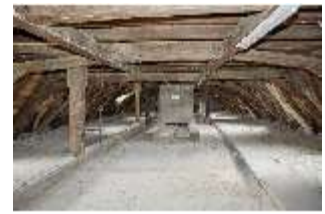
BaRes.II, Gebsattelbau, Dachstuhl, DI017652, BSV
