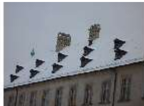
BaRes.I, Gartenseite, Verschneites Dach, DI022647, BSV-
