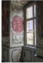
BaRes.II, Fensterlaibung, Kaisersaal, R. 9, DI020585, BSV
