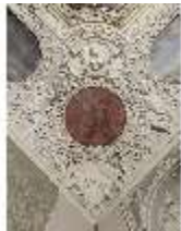
BaRes.II, Rondo an der Decke, Vorzimmer R. 20, DI015613, BSV
