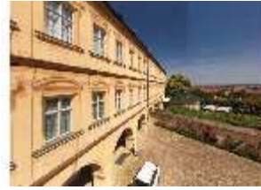
BaRes.I, Luftaufnahme Fassade Gebtsattelflügel, DI025154, BSV
