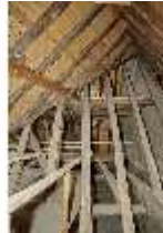
BaRes.II, Gebsattelbau, Dachstuhl, DI017654, BSV
