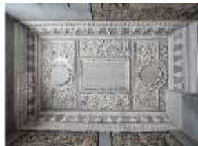
BaRes.II, Deckenstuckaturen, Gesamtansicht, Äußeres Vorzimmer, R. 1, DI015668, RSV
