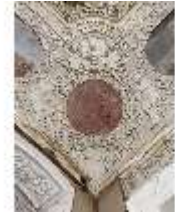
BaRes.II, Rondo an der Decke, Vorzimmer R. 20, DI015612, BSV
