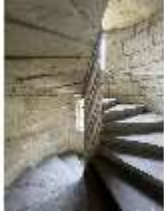
BaRes.II, Wendeltreppe, DI020692, BSV-
