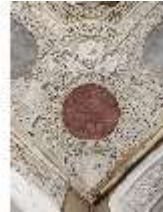
BaRes.II, Rondo an der Decke, Vorzimmer R. 20, DI015542, BSV
