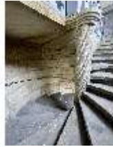
BaRes.II, Wendeltreppe, DI020689, BSV-
