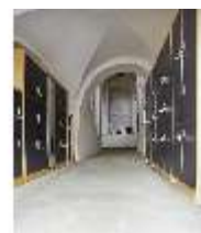
BaRes.II, Eingangsbereich, barrierefrei, DI017658, BSV
