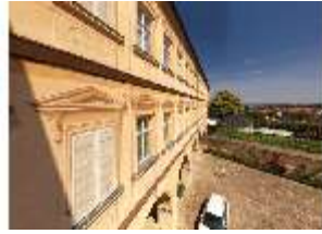
BaRes.I, Luftaufnahme Fassade Gebtsattelflügel, DI025153, BSV
