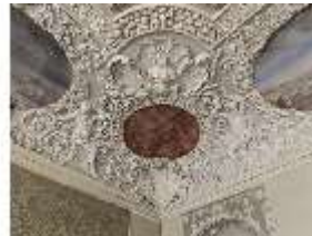
BaRes.II, Rondo an der Decke, Vorzimmer R. 20, DI015615, BSV
